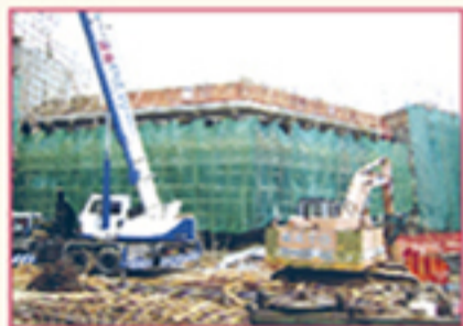
新院舍施工情況
